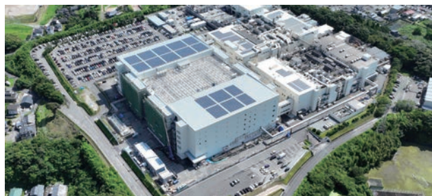
写真-1 建物外観(南東面)
