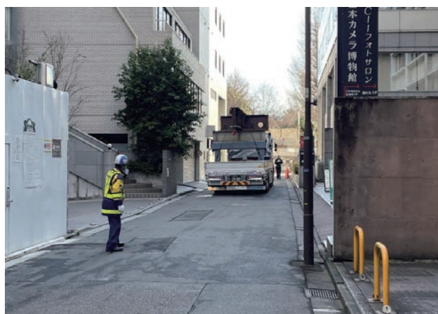
写真-3 誘導員を配置しての逆走による搬入状況
