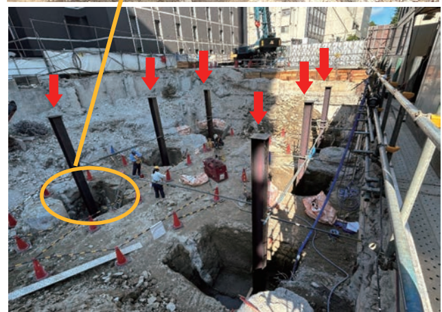
写真-4 構台杭設置状況(↓: 構台杭)
