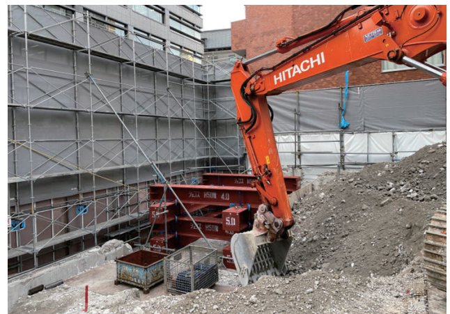
写真-5 置き構台設置状況
