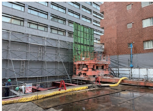
写真-7 全周回転掘削機設置状況
