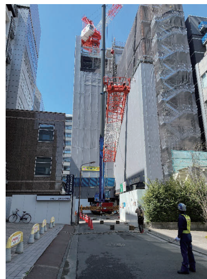
写真-15 同 解体状況
