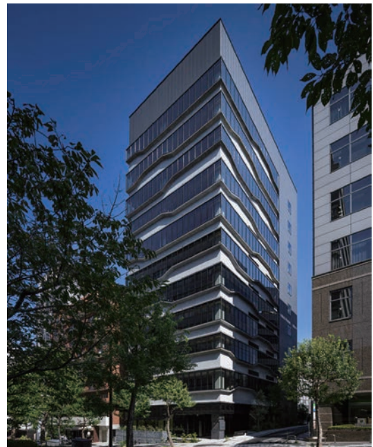
写真-1 完成建物外観
