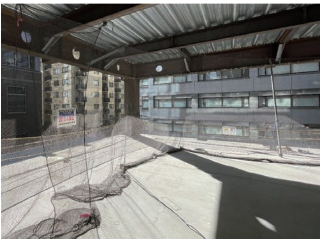
写真-12 内側垂直ネット設置状況
