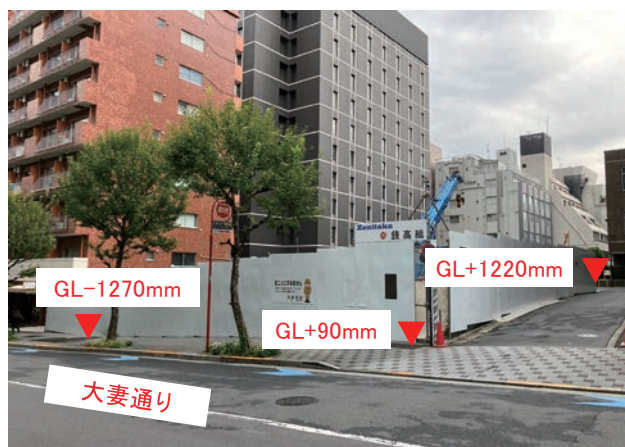
写真-2 大妻通り側道路高低差状況
