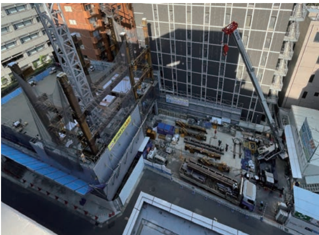
写真-11 鉄骨建方状況
