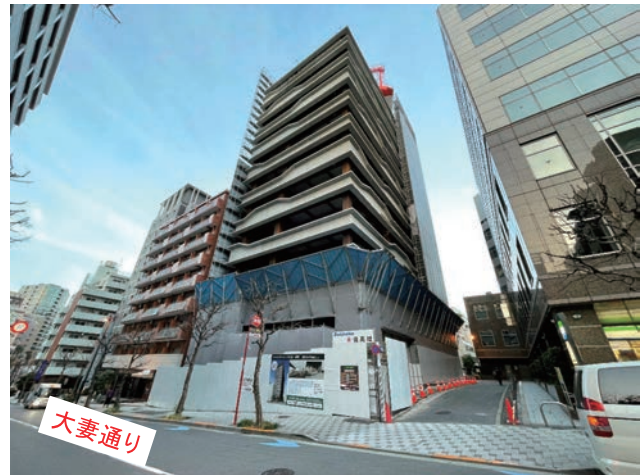
写真-13 PCCW 取付完了状況
