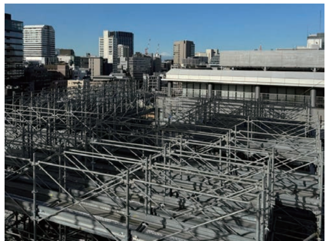
写真-14 外部足場ユニット地組状況
