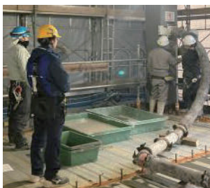
写真-10 充填コンクリート圧入状況
