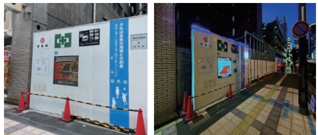
写真-7 仮囲い内モニター
