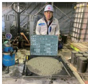
写真-8 コンクリート現場受入検査状況
