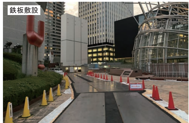
写真-1 車路鉄板下 防音対策
