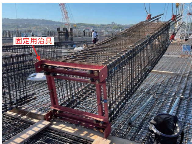
写真-1 柱筋固定用治具による建て起こし状況
