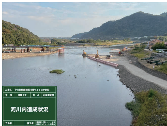
写真-1 河川内瀬替え施工状況
