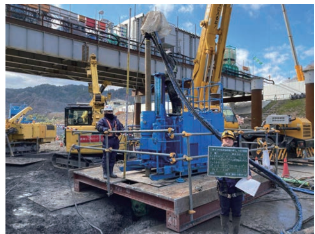
写真-4 高圧噴射攪拌工施工状況
