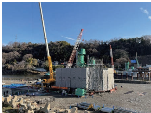
写真-2 ニューマチックケーソン施工
