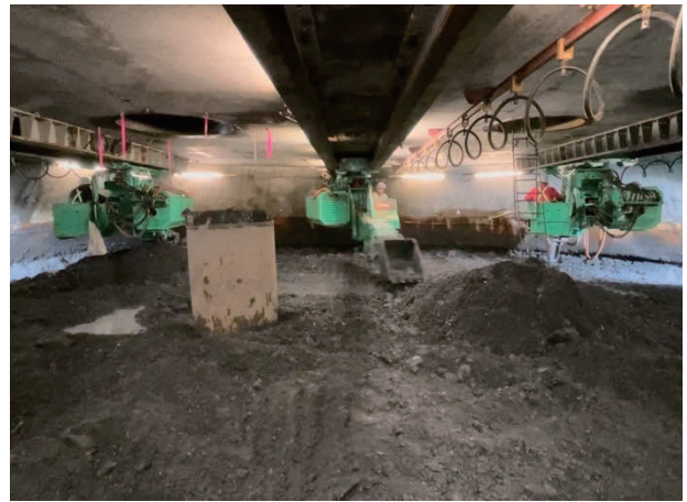
写真-5 函内沈下掘削状況
