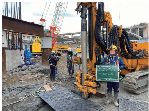
写真-3 ボーリング工施工状況
