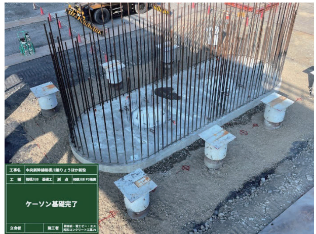
写真-6 ケーソン基礎完了
