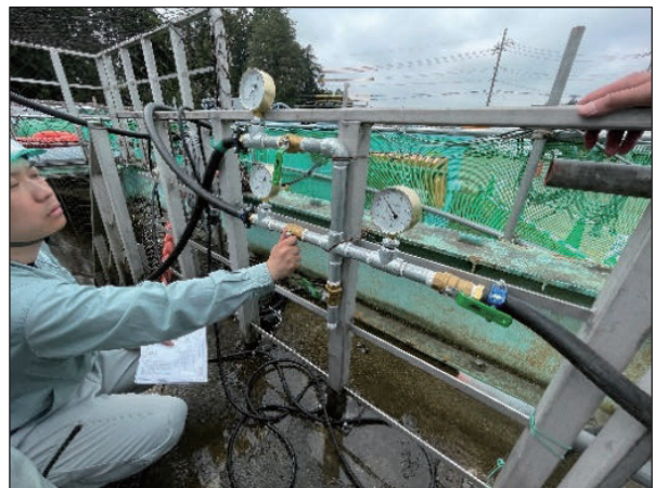
写真-6 エントランスチューブ圧力調整状況
