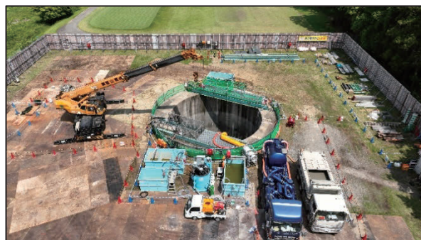
写真-8 底板汚泥清掃状況
