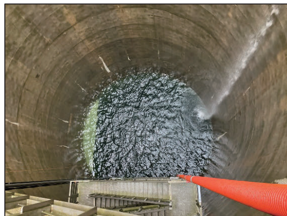
写真-2 到達立坑注水状況
