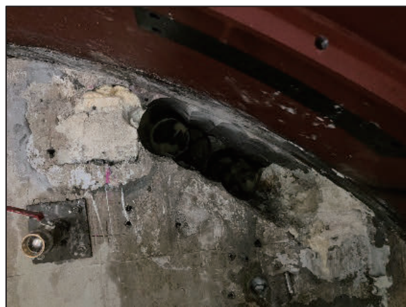
写真-1 保護ピット通過部削孔状況
