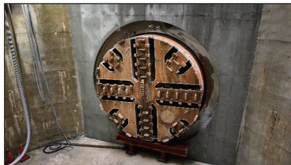
写真-9 シールドマシン到達状況
