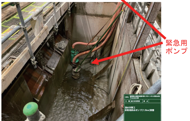
写真-3 緊急対応状況写真
