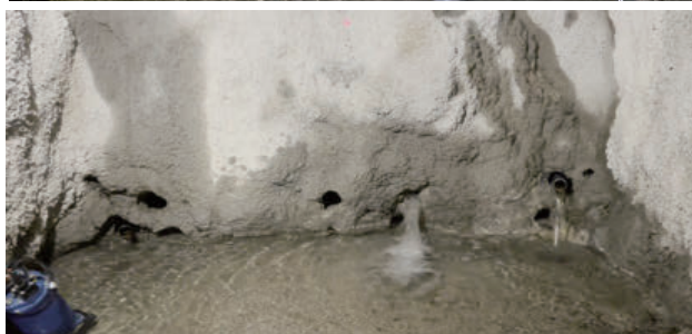
写真-5 水抜き工実施状況
