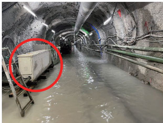
写真-2 受電設備の嵩上げ
