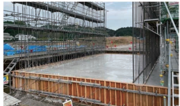
写真-2 打設後の状況
