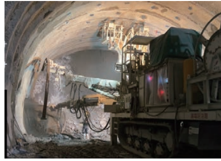
写真-4 コンクリート吹付機
