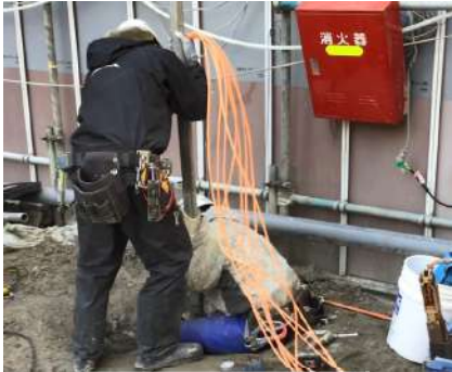
(b) 傾斜計の設置
