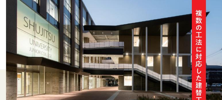
耐震不足であった旧A館を、新A館（事務室・研究室等）とD館（大教室）に建て替えました。両館とも本体建物はRC造でしたが、部分的にS造があり、RC造を構築した後にS造を施工するため、その方法や工程に苦心しました。また、D館は14m×21mの無柱大空間の確保のため、梁にPRC工法が採用されており、PRCの施工精度に技術力が求められる建物でした。
