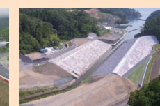
12 港川河川災害復旧工事
