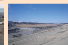
18 中間貯蔵に係る保管場設置等工事(双葉町)
