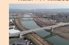
17 東北中央自動車道伊達大橋
