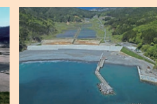
6 農地海岸保全施設災害復旧事業小谷島地区
