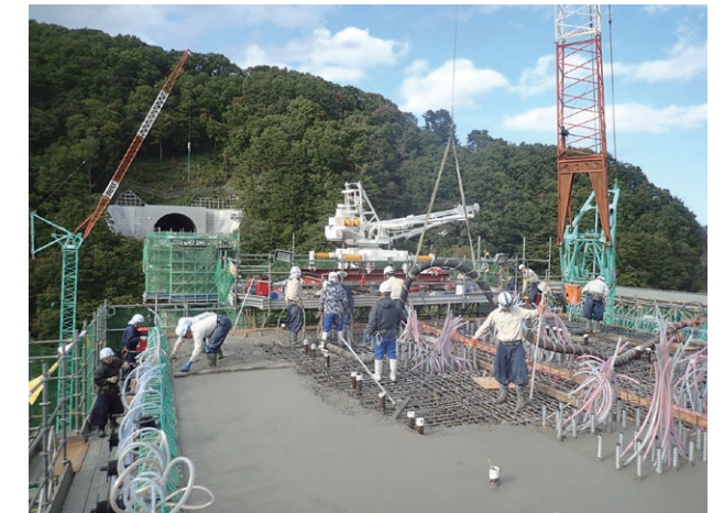
コンクリート打設
