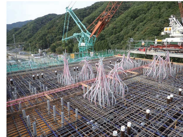
鉄筋と後施工用注入用ホース
