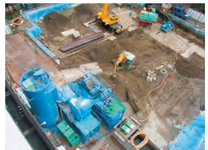
山留め施工状況 (京都大学(北部)物理国際先端研究棟新営工事)
