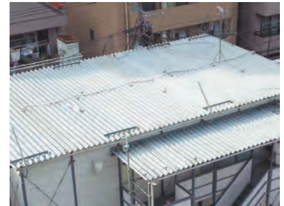
屋根散水システムの設置 （川崎市中幸町3丁目再開発計画工事）
