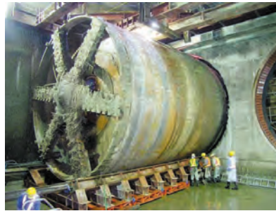
神沢駅立坑へ到達 神沢駅立坑でのシールド機の到達状況。180度回転し、右側の発進部から再発進します。
