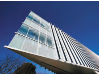
太陽光パネル組込型鉛直ルーバー 太陽光発電パネルを組み込んだ鉛直ルーバーで建物を覆っています。
