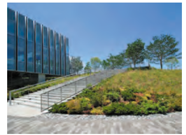
緑の丘への階段 斜めPC梁の上部分となる斜面には、近隣から採取した在来種の種子による植栽を行いました。
