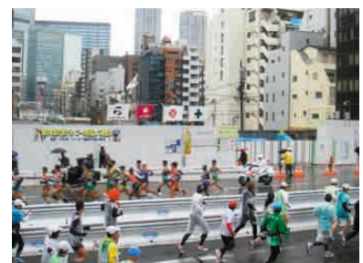
東京マラソンのために路面を整備 （環状2号線交差部工事）
