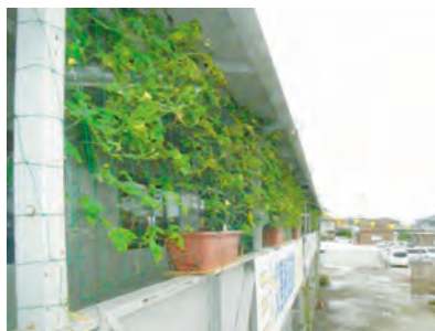
グリーンカーテン （新潟勤務者医療協会 下越病院工事）
