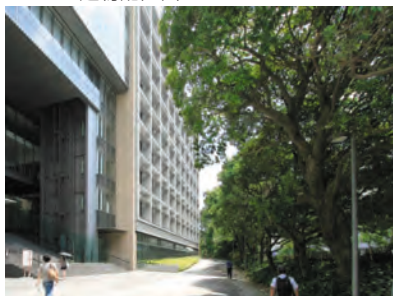
正門付近 正門付近の既存樹木を保護しながら施工を行いました。
