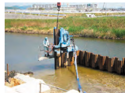
生分解性油脂を使用した矢板圧入機 （東九州自動車道赤岩川橋工事）
