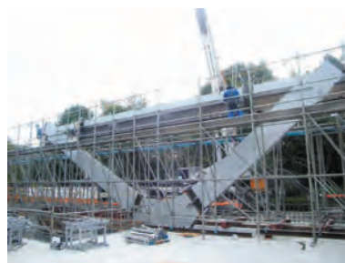
Y字鉄骨の建方状況
