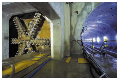
相生山駅立坑 左は1番線シールドの到達状況、右は2番線軌道を工事中。
