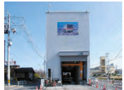
防音ハウス 相生山立坑の防音ハウス。
