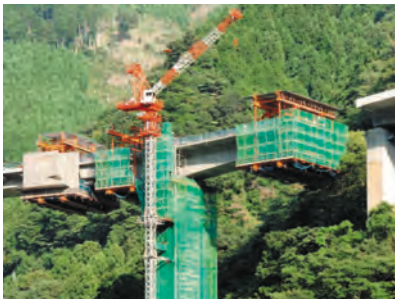
落下防護した移動作業車 P4橋脚からの張出し施工。熊野川への環境配慮から、片側の移動作業車（向かって左）に落下防護を設置しました。
