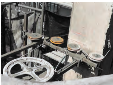
ワイヤーソーによる柱の切断 （大分医療センター病棟解体工事）
