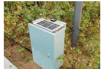
太陽光による自動灌水設備
