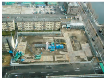
全景 (横浜市海岸通団地建替工事)
