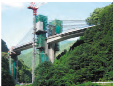
P4橋脚 主塔の施工
