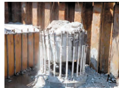
杭頭鉄筋にプラスチックベニヤを取り付けて杭頭処理時のはつり作業を低減 （広島県十日市町一丁目分譲マンション新築工事）
