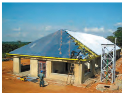
研究・管理棟施工 屋根仕上げは折板葺の上にセメント瓦葺で、現地のメンテナンス状況を考慮した構造です。
