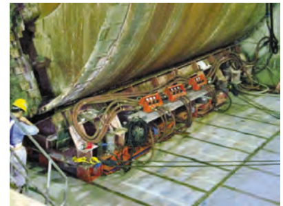
エアークャスター シールド機の下にキャスターバッグを設置した状況。ワイヤーを使って回転させます。
