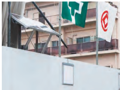
防犯灯への利用 (広島市十日市町一丁目分譲マンション新築工事)
