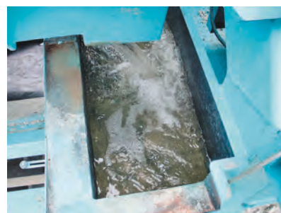
アクアセパレート工法 施工状況
