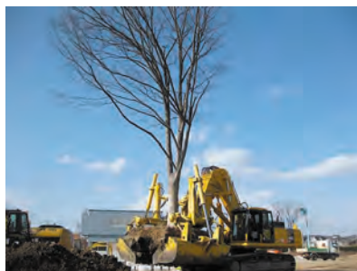
専用重機による樹木の運搬 （三井アウトレットパーク倉敷工事）
