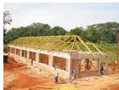
研究者宿舎棟の施工 壁には吸水率の低い石器質系大板レンガを使用し、吸水による内部欠陥を防ぎました。
