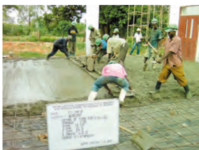
ワークショップ棟スラブ施工 直押しコンクリート仕上げの施工が雨季と重なったため、屋根工事後に実施しました。
