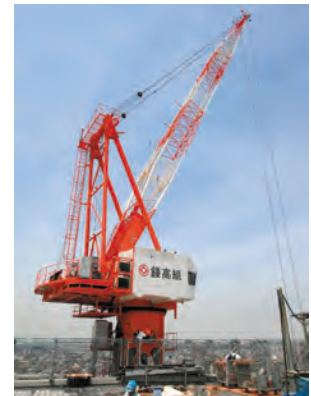
タワークレーンの回生電力利用 (川崎市中幸町3丁目再開設計画工事)
