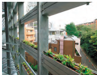
南面・壁面緑化ルーバー
