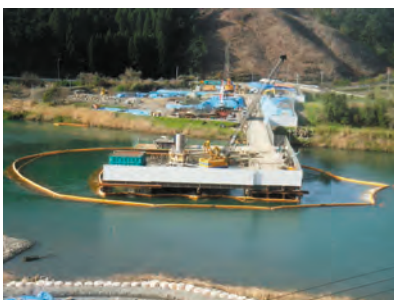
水質汚濁防止対策 （東九州自動車道耳川橋工事）
