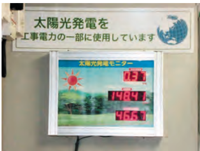
発電量の見える化 (横浜市海岸通団地建替工事)
