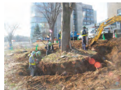
ケヤキの掘り取りと根巻き （仙台東西線青葉山駅工事）
