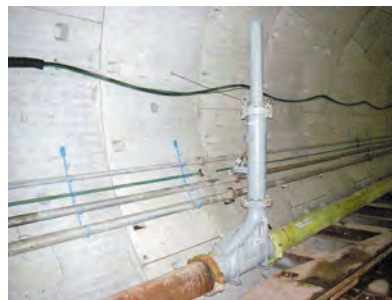
サイレントダンパー 掘削土砂圧送時の騒音を防止するための消音装置。
