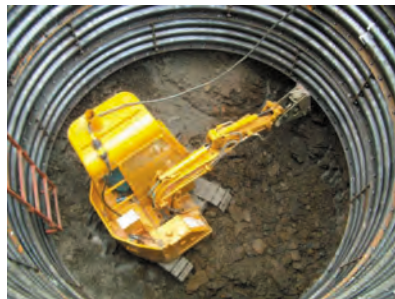
電動バックホウ A2橋台の深礎杭掘削は、CO 2 排出量を低減するため電動バックホウを使用しました。
