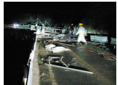
台風時の災害復旧 台風時に県道をふさいだ近隣工区の障害物を一晩で撤去しました。
