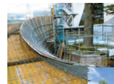
既存樹木の保護施工中
