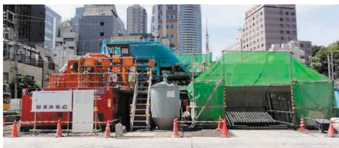
アクアセパレート工法 施工状況
