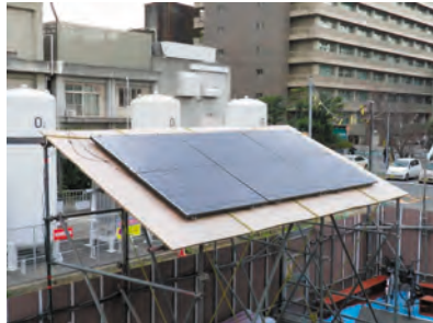
太陽光発電 (京都大学(南部)先端医療器機開発・臨床センター工事)
