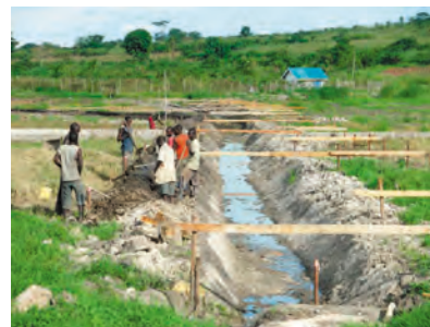
試験圃場の施工 既存河川の流路を整備します。
