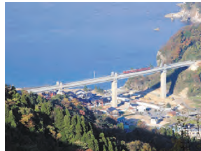
西日本旅客鉄道 山陰本線余部橋りょう
