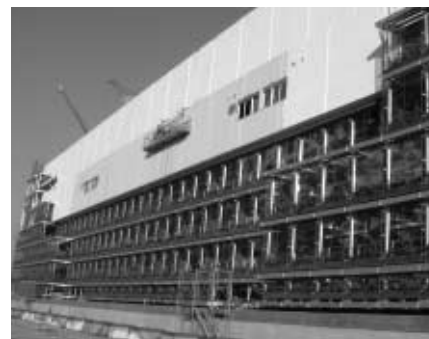
南面壁面緑化施工状況写真 02.1.12
