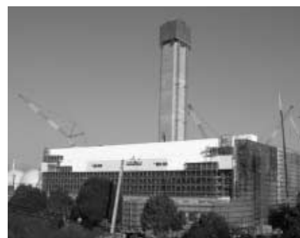
工事中の全景写真(南東面) 02.1.12
