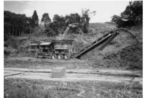
伐根・伐採材チップ処理状況
