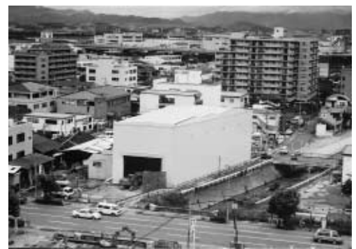
防音ハウス設置状況
