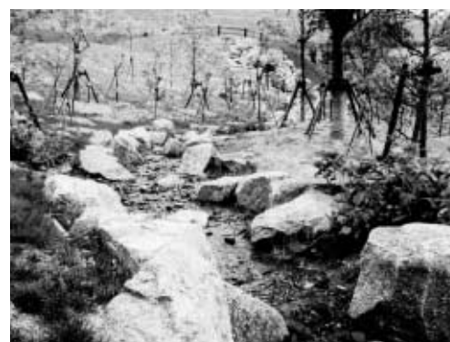
佐川四国健康増進センター造成工事(当社施工)
