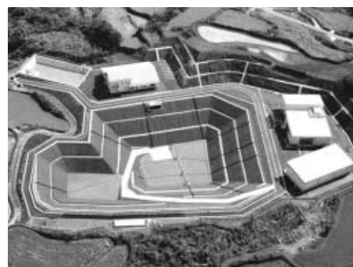
福江市一般廃棄物最終処分場（当社施工）
