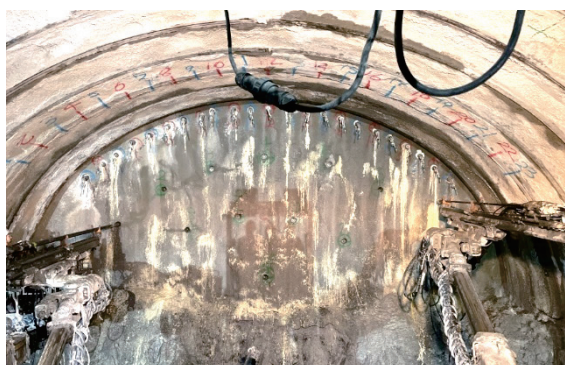
写真－3 長尺鏡ボルト工施工状況
