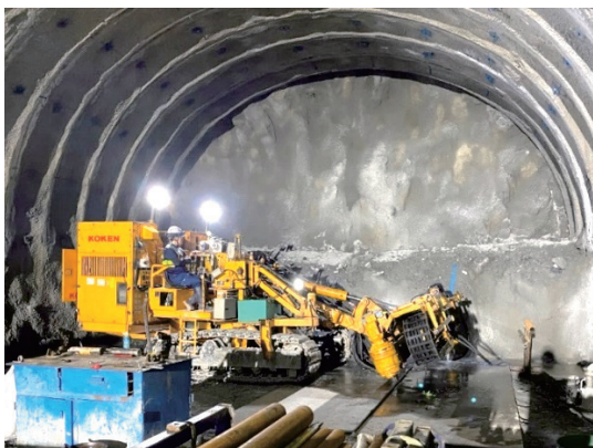
写真-5 先進調査ボーリング実施状況
