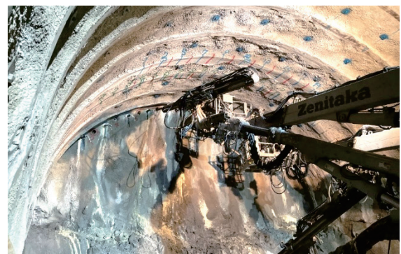
写真-2 長尺鋼管先受工施工状況
