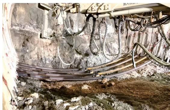
写真－4 インバートストラット施工状況
