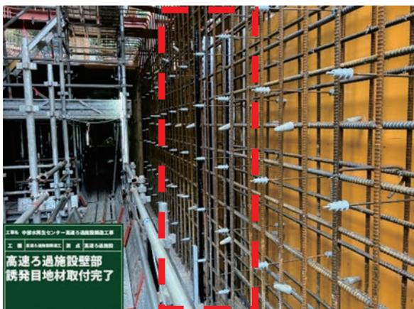
写真-2 誘発目地設置状況 (打込み前)
