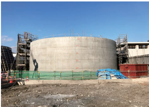
写真-1 構築後の立坑躯体
