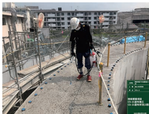
写真-7 改質剤の塗布状況（水平打継面）
