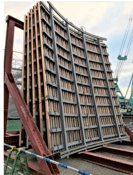
写真-9 型枠のユニット化状況
