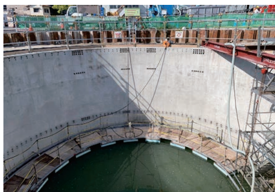
写真-6 立坑内水替え状況
