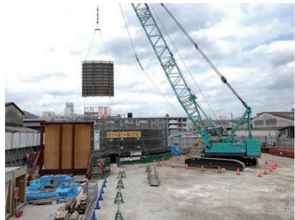
写真-10 ユニット化した型枠の組立状況
