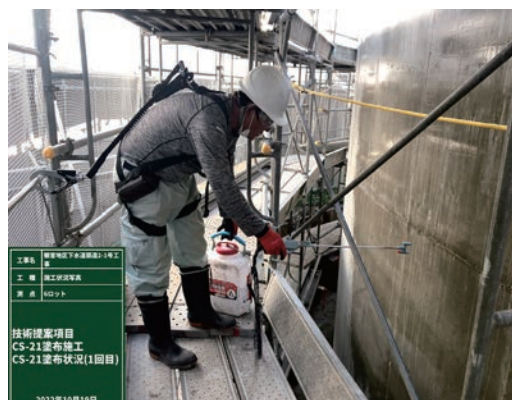
写真-8 改質剤の塗布状況（外周面）
