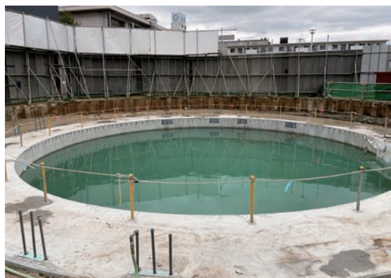
写真-4 立坑躯体の圧入沈設完了状況
