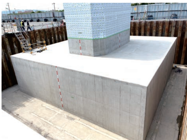
写真-2 フーチング施工完了
