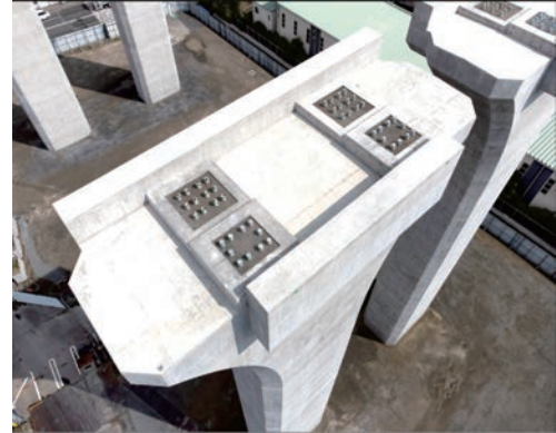
写真-10 施工完了全景
