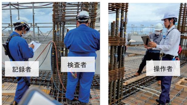
写真-1 ガス圧接継手の検査状況
