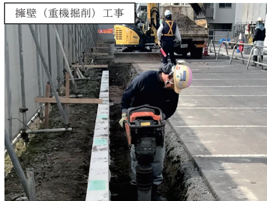
写真-3 仮囲い・擁壁重機掘削 施工中状況
