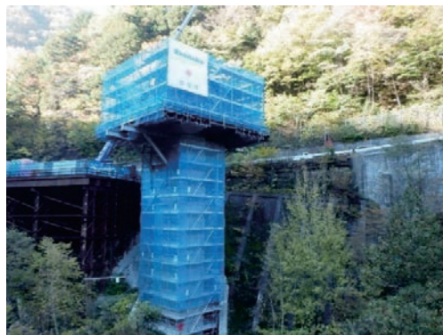
写真-6 P1 柱頭部のブラケット式支保工
