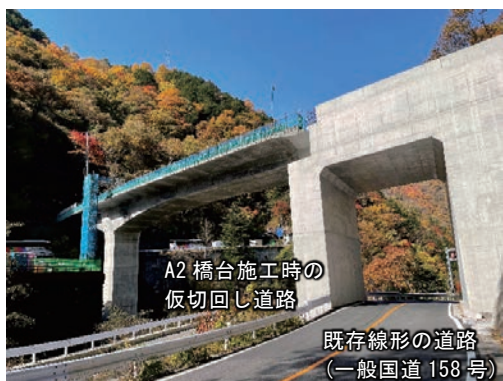
写真-5 A2 橋台施工後の道路線形復旧状況
