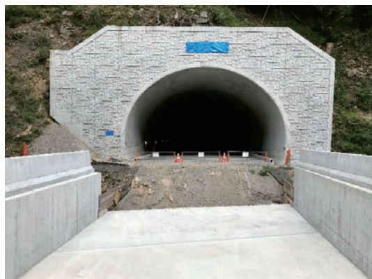
写真-10 A2橋台の踏掛版設置後の状況
