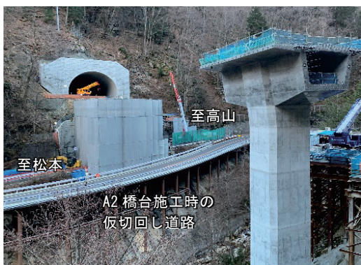
写真-4 A2 橋台施工時の仮切回し道路
