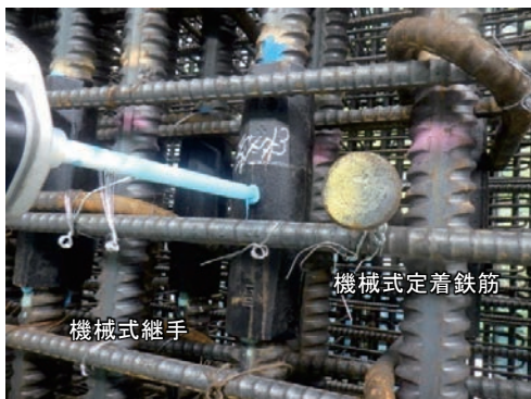
写真-3 P1 橋脚の鉄筋組立状況
