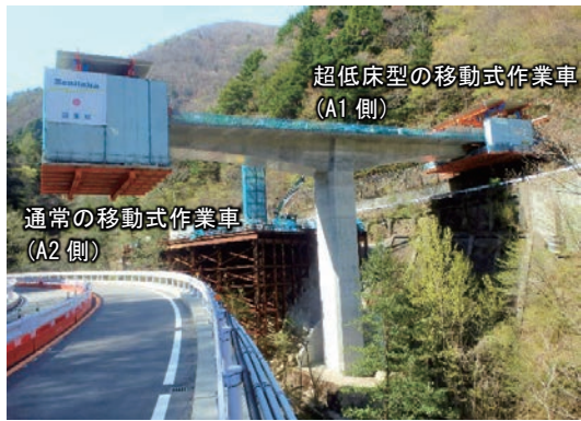
写真-8 張出架設による上部工の施工状況 (A2側)
