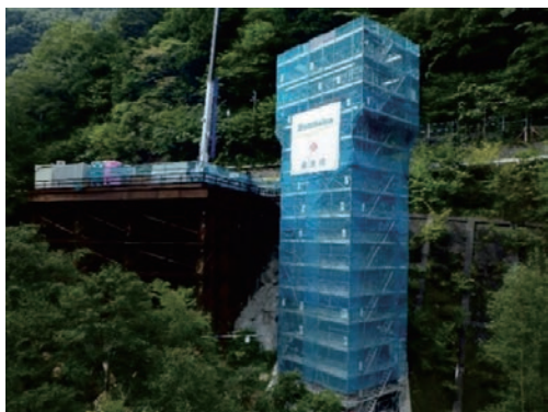
写真-2 P1 橋脚の施工状況
