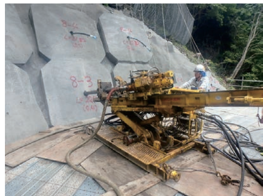
写真-12 A1橋台背面グラウンドアンカー施工状況
