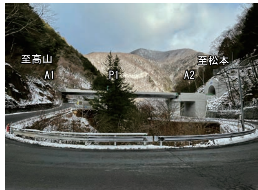
写真-1 施工箇所全景 (2022 年 12 月撮影)
