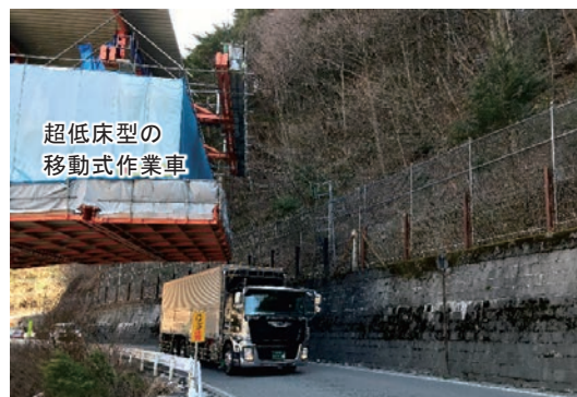
写真-7 国道 158 号上の張出架設状況 (A1 側)
