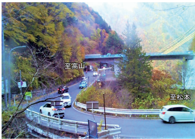
写真-14 行楽シーズンの通行状況（一般国道158号）
