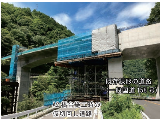
写真-9 A2側径間の固定式支保工 (主桁閉合時)
