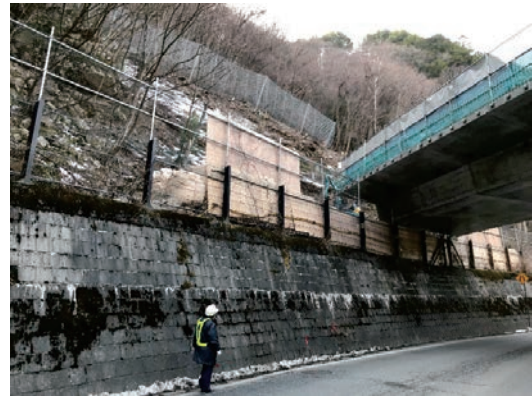
写真-13 A1 橋台仮設落石防護柵設置・監視員配置
