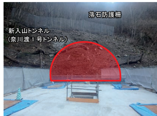
写真-11 A1橋台背面の落石防護柵設置完了
