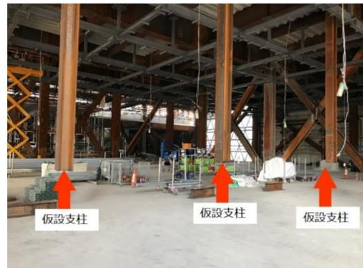
写真-4 仮設支柱切断中の状況
