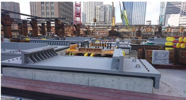
写真-2 衝突ばね鉄骨の取付状
