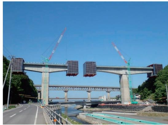
写真-1 張出し施工状況
