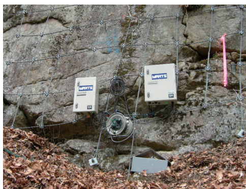
写真-2 振動レベル計設置状況
