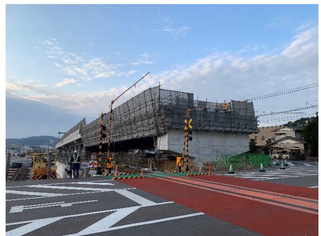
写真-10 JR 営業線近接工事施工状況
