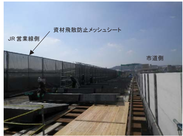
写真-8 JR 側飛散養生メッシュシート設置
