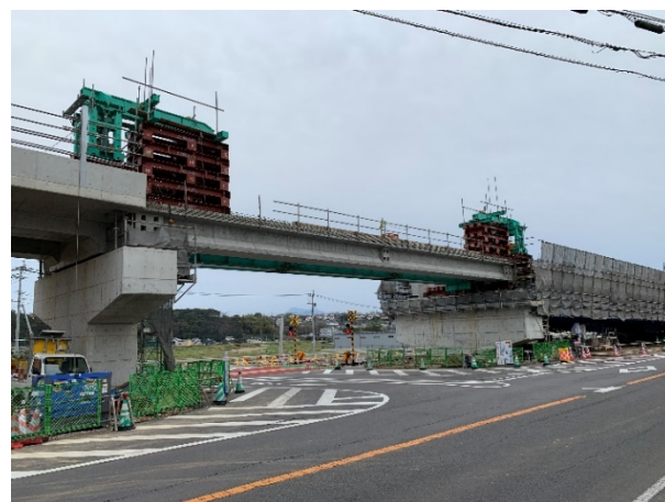
写真-7 栄田 Bv 主桁架設状況
