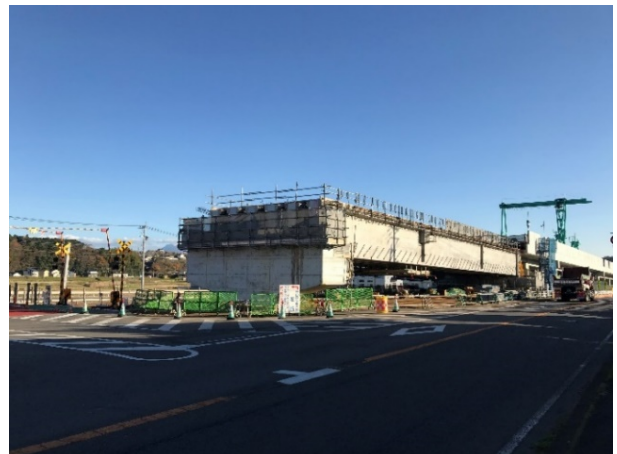
写真-5 第3栄田 BL 主桁架設完了
