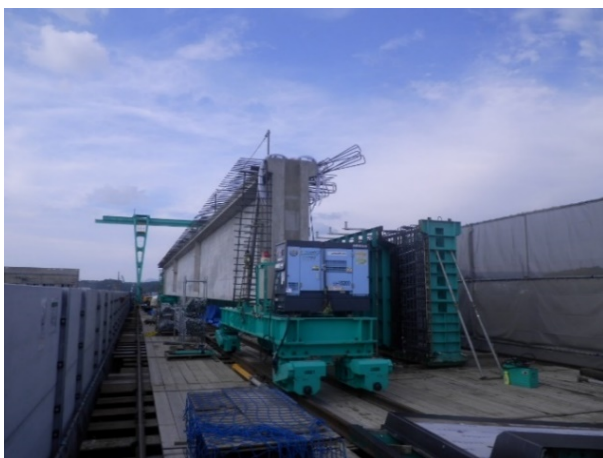
写真-2 主桁製作および仮置き（第3栄田 BL）
