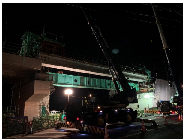
写真-6 栄田 Bv 主桁架設状況
