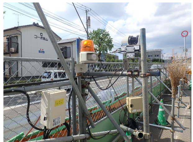
写真-9 市道側レーザーバリア設置
