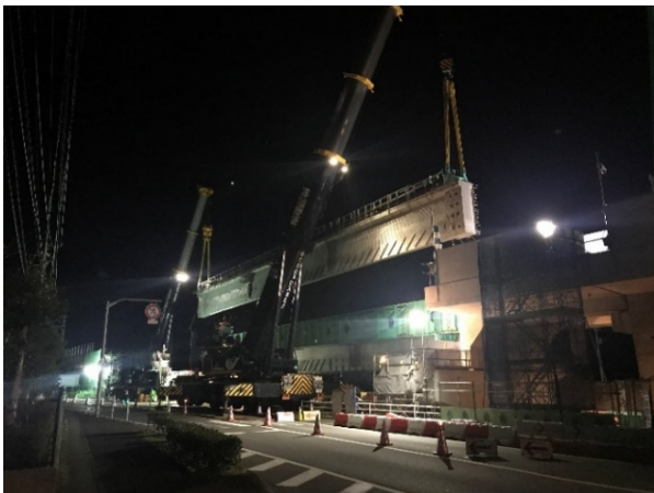
写真-4 第3栄田 BL 主桁架設状況
