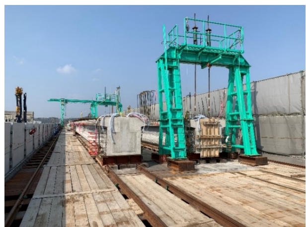
写真-3 主桁製作および仮置き（栄田 Bv）
