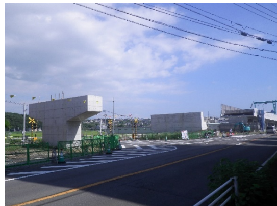
写真-1 PC 桁架設箇所全景
