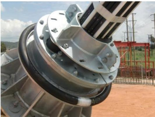
写真-17 高減衰ゴムを用いた制振ダンパー
