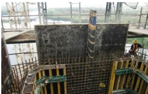
写真-8 エアチューブを用いたスリット部の型枠
