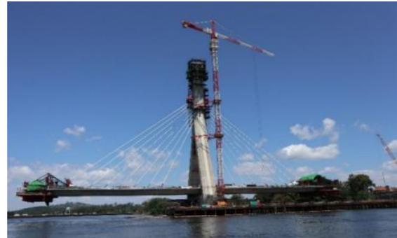
写真-10 P1主塔からの張出し施工
