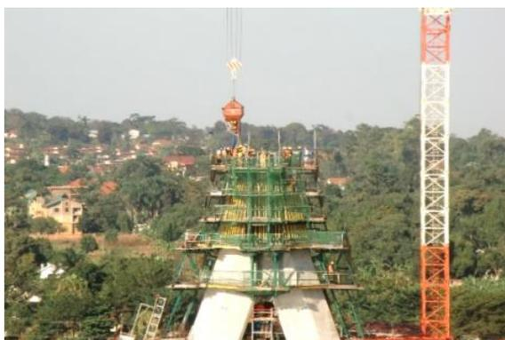
写真-7 バケットによる主塔コンクリート打設
