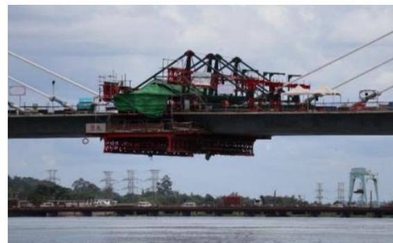
写真-11 P1主塔側移動作業車による中央閉合
