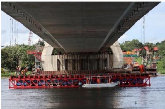
写真-14 下段作業台の水面への降下状況
