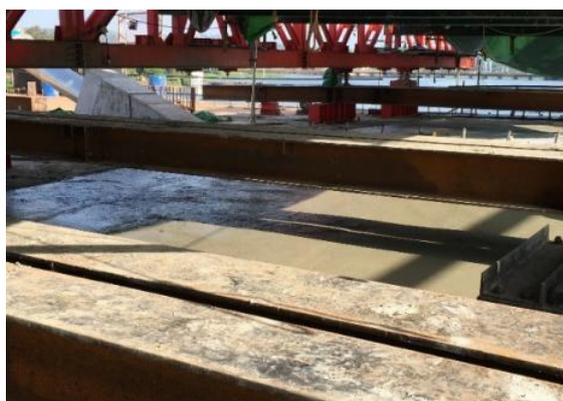
写真-15 中央閉合部打設状況
