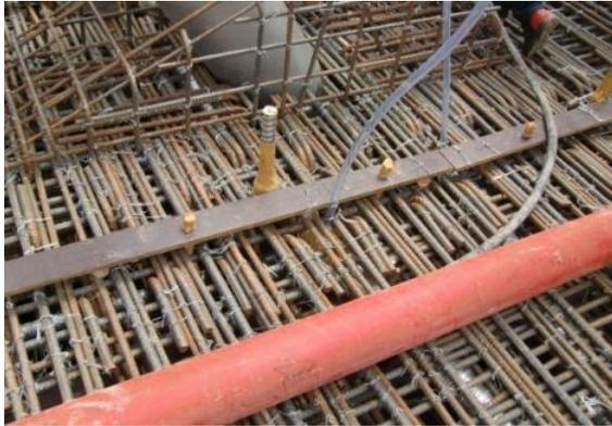
写真-13 主桁の過密配筋状況
