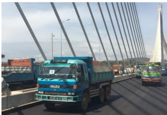
写真-21 静的載荷試験
