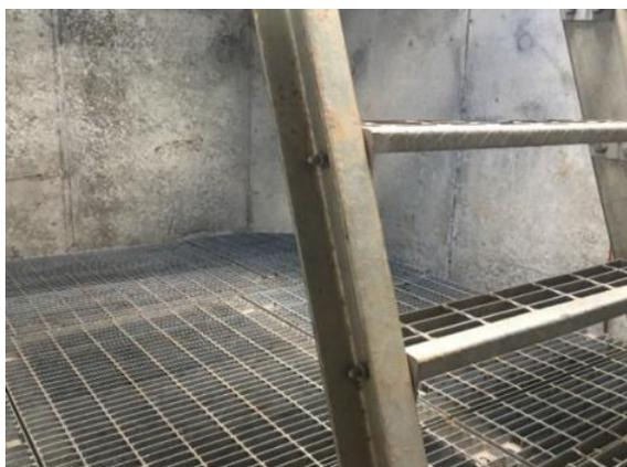
写真-9 グレーチングを用いた主塔内検査路
