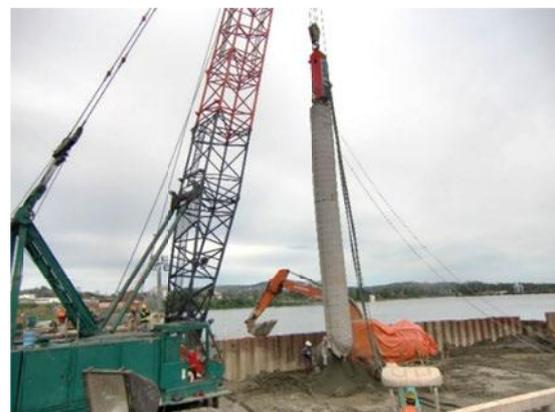
写真-2 ダウンザホールハンマー工法による先行削孔状況
