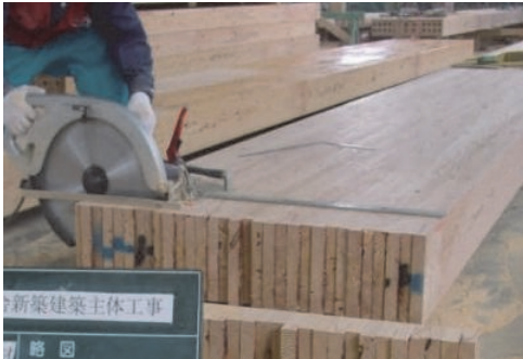
写真-16 切断加工状況
