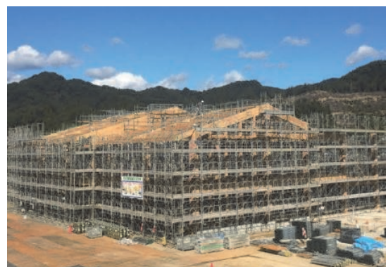
写真-39 建て方完了状況
