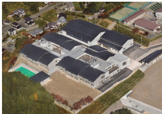
写真-1 完成全景
