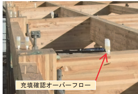
写真-37 接続部充填作業完了(柱-梁部)
