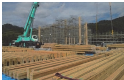
写真-26 建て方作業状況
