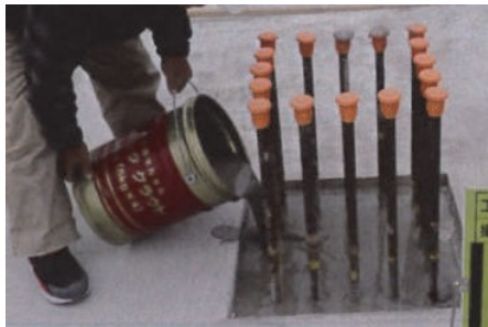
写真-25 台座モルタル施工状況
