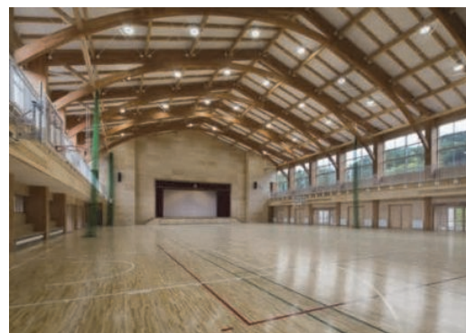
写真-23 金物の露出が無い状況(体育室)
