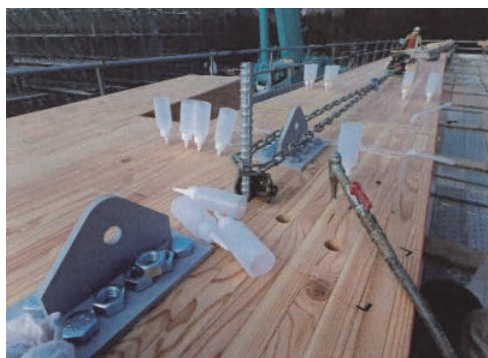
写真-42 大梁接続作業状況
