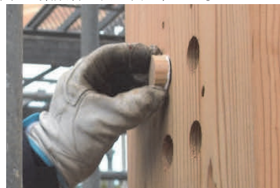
写真-31 木栓作業状況(柱頭部)
