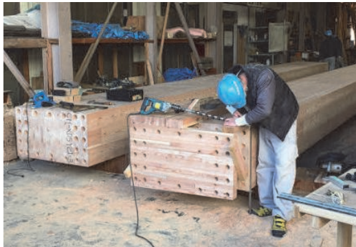
写真-18 大断面集成材仕上げ加工状況
