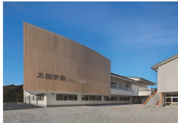
写真-2 エントランス外観
