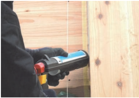
写真-32 シーリング作業状況
