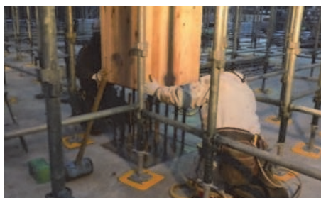
写真-27 建て方状況(柱脚部)
