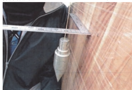
写真-30 柱建入れ検査状況
