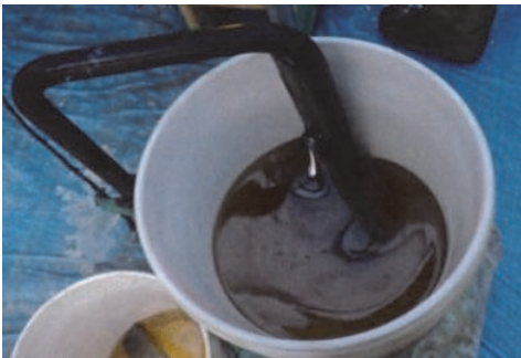
写真-33 充填用樹脂攪拌作業状況
