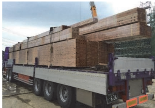
写真-22 運搬積込状況
