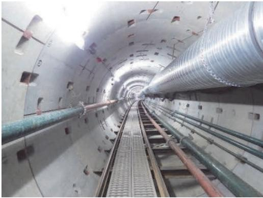
写真-7 φ600 坑内吸気配管
