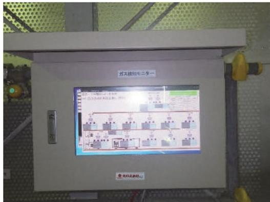
写真-6 ガス濃度モニター (立坑入口)
