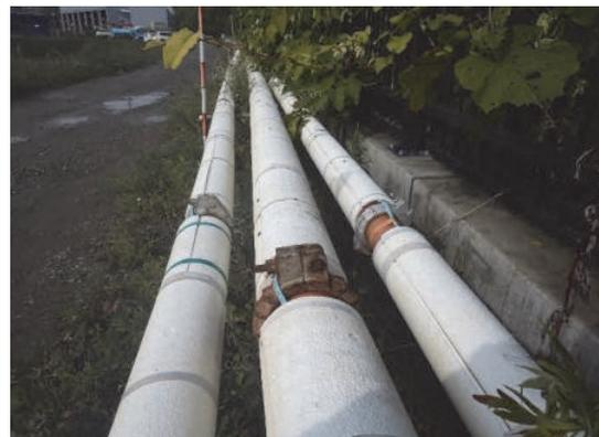
写真-11 送排泥管凍結養生
