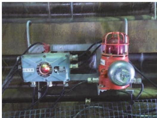
写真-5 ガス検知警報器 (耐圧防爆、立坑)
