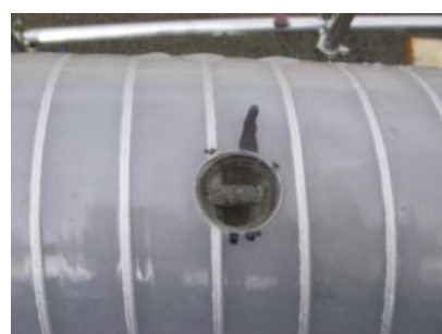
写真-9 Gap 方式の充填状態
