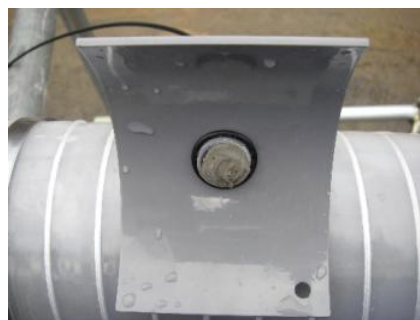
写真-7 充填後のセンサー状態(Twin Fiber 方式)
