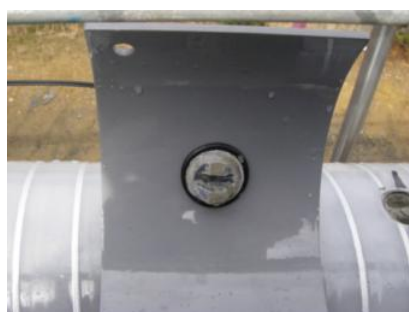
写真-8 充填後のセンサー状態(Gap 方式)
