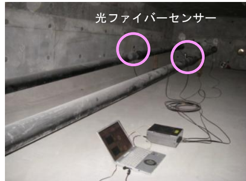
写真-12 外ケーブルの充填計測状況
