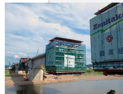
張出し架設の様子
