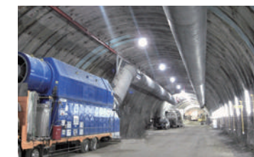
坑内の換気装置
