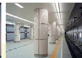
営団地下鉄(現 東京メトロ) 半蔵門線 大手町駅
