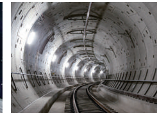
名古屋市営地下鉄 桜通線 相生山駅～神沢駅
