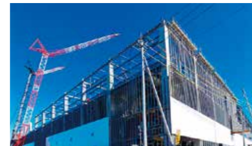
高所作業車を利用した無足場工法
