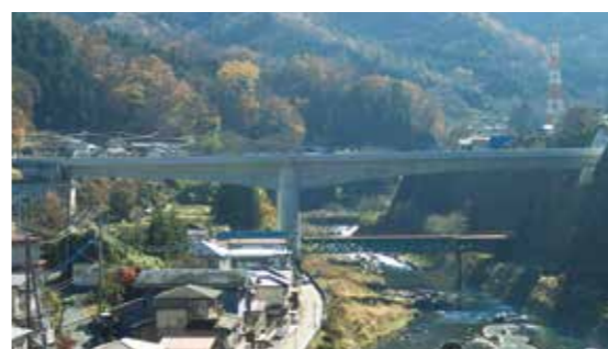
大月バイパス桂川橋上部工事
