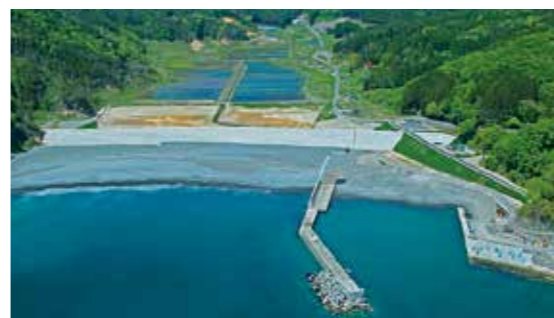
農地海岸保全施設災害復旧事業 小谷鳥地区第1号工事
